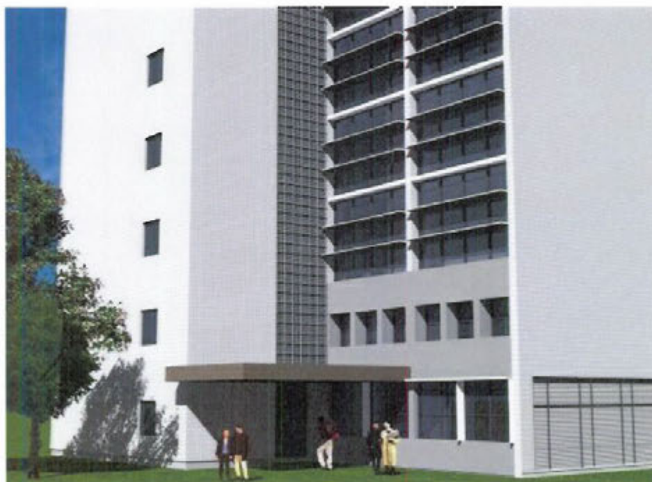
Fig. 4 – Maquete eletrônica mostrando a entrada principal do prédio, após a conclusão da obra. Notar que os dois primeiros pavimentos já se encontram edificados (ver Fig. 1).
